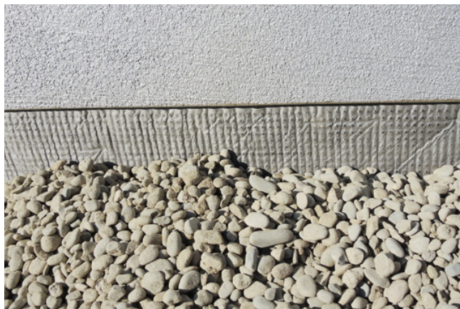
Fig. 6 Natte drainante résistante à la compression (voile non-tissé posé à l'extérieur), protégeant la façade contre toute détérioration mécanique consécutive au remblayage avec du gravier rond.
