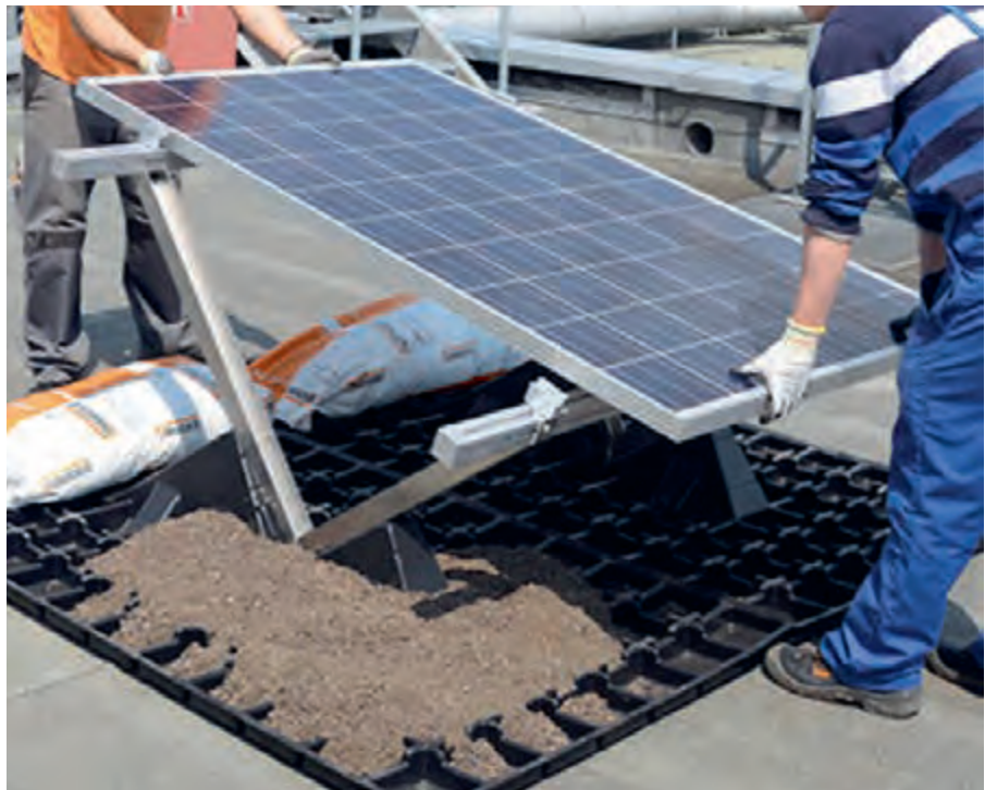
Abbildung 6: Auflastsystem für PV-Aufständerung, Quelle: Bauder
