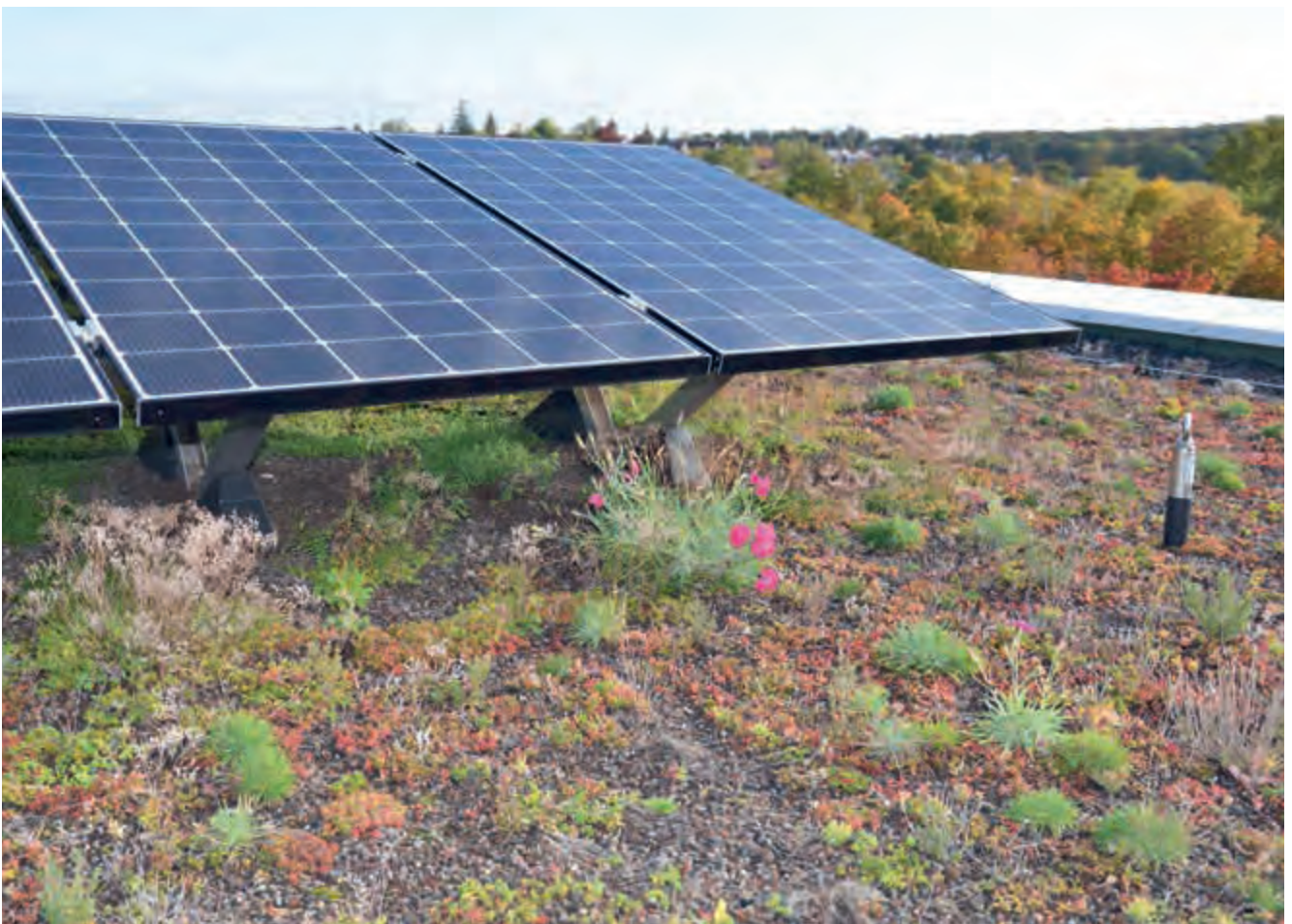
Abbildung 21: Absturzsicherung, Quelle: contec
