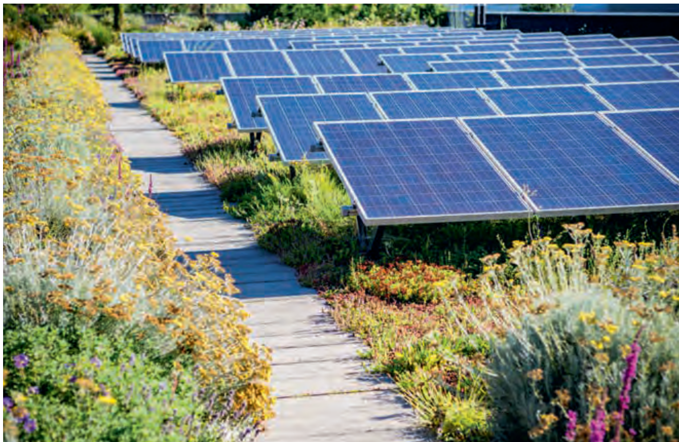
Abbildung 3: Kombination Intensiv-/Extensiv-Dachbegrünung neben PV-Anlage, Quelle: Contec
