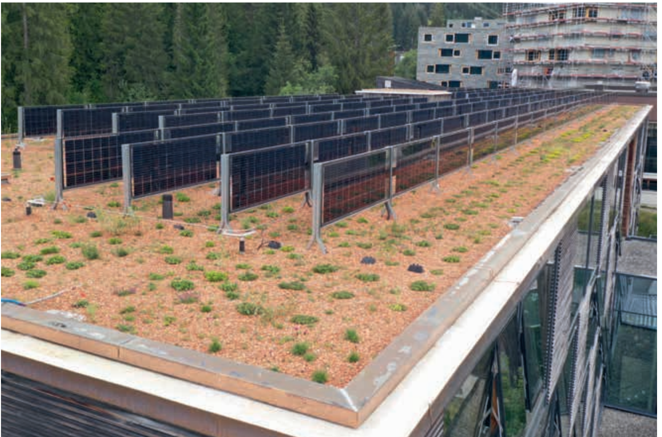
Abbildung 17: Senkrecht aufgeständerte PV-Module mit minimalem Substrataufbau, Quelle: Zinco
