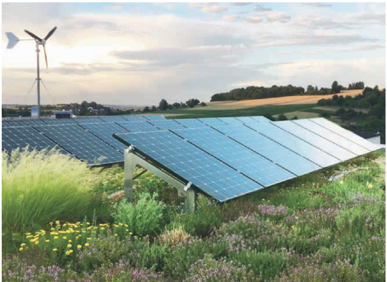
Abbildung 10: Kombination Intensiv-/Extensiv-Dachbegrünung neben PV-Anlage, Quelle: Zinco
