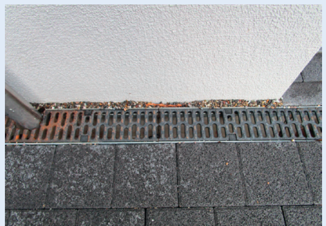
Bild oben: Entwässerungsrinne und Flachstahl roh, Asphaltbelag.
