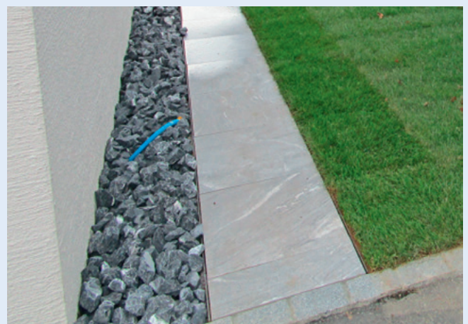
Bild oben: Rundkies Korngrösse 32/64 mm, Randabschluss 20 cm.
