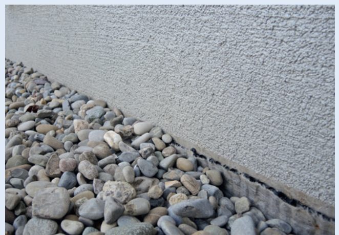
Bild oben: Schotterstreifen gemischte Korngrössen 15/30 mm und 50/80 mm.
