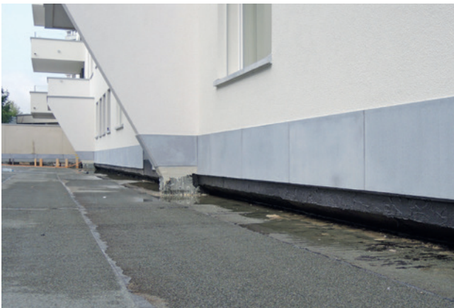
Abb. 3 Spritzwasserschutz durch Sockelelemente.
