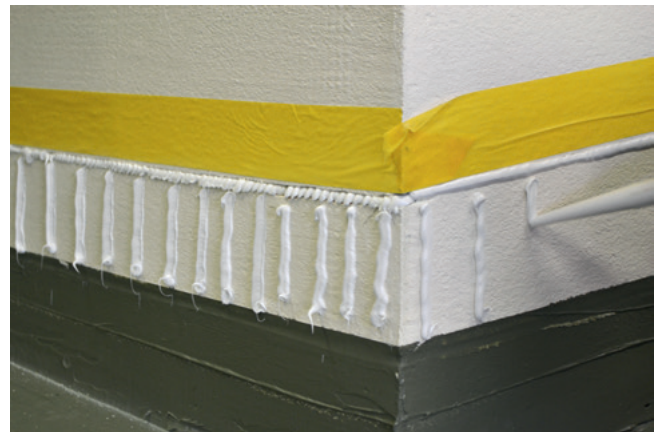
Abb. 11 Vertikales Auftragen von Klebstoff zur Montage des Sockelschutzbleches.
