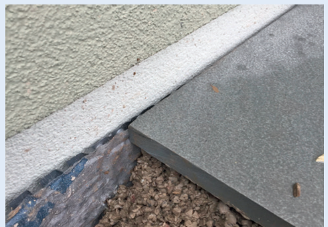
Bild oben: Edelstahl Schutzschiene geschlitzt.
