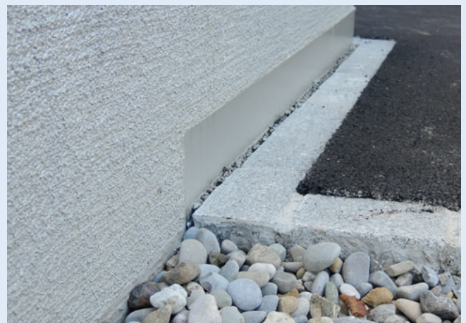
Bild oben: Bundstein in Beton versetzt, Asphaltbelag.
